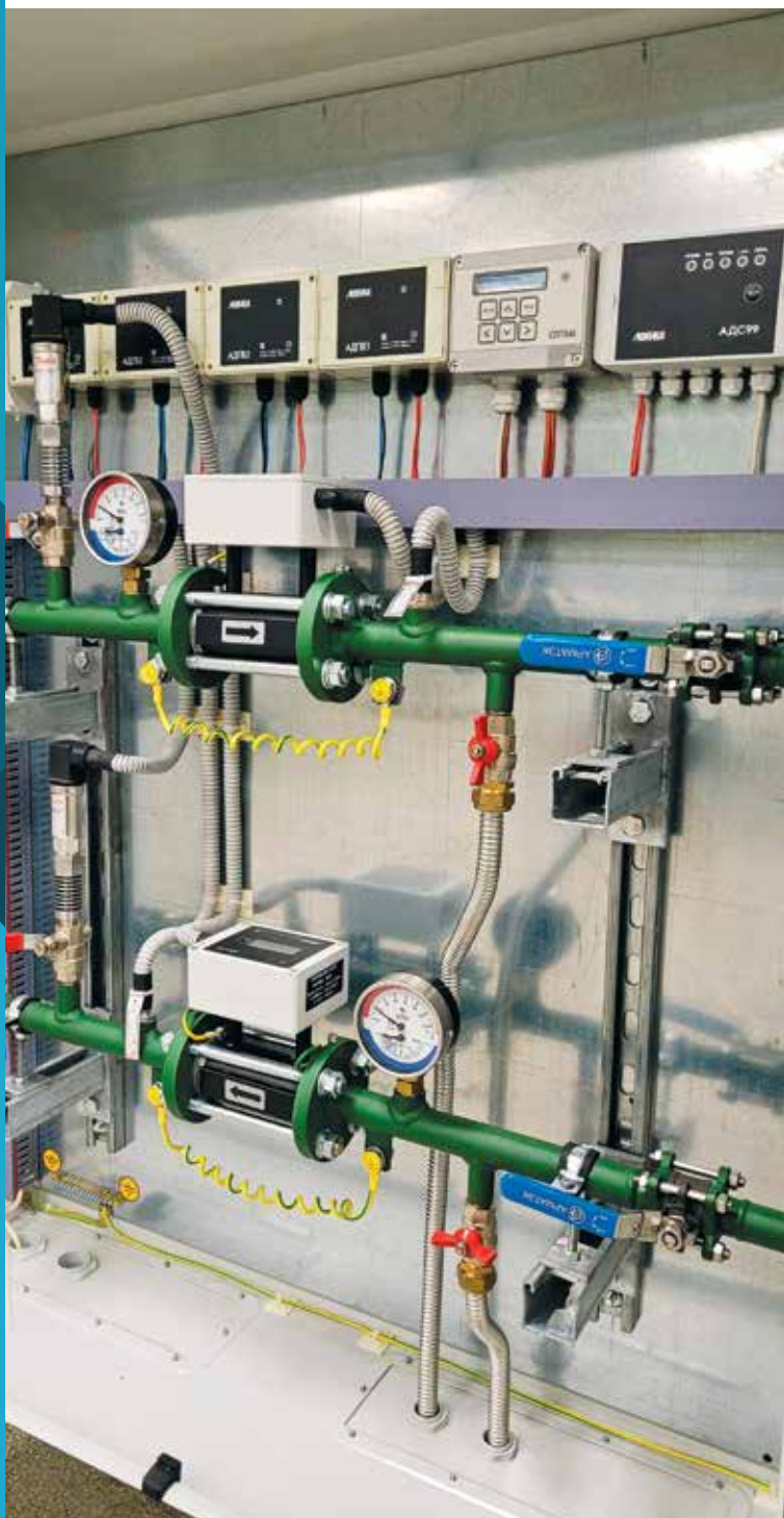
Современный узел учета тепловой энергии на базе тепловычислителя VI поколения СПТ940 производства АО НПФ «Логика»
