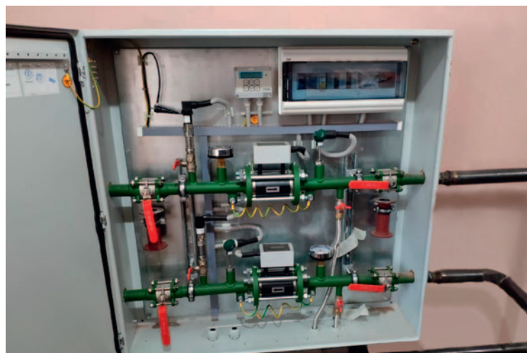
ЛГК410 в составе блочного узла учета в антивандальном шкафом исполнении на объекте Минобороны
