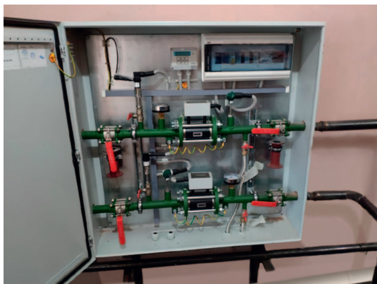
ЛГК410 в составе блочного узла учета «ТЭМ®-УУ-Ш» в антивандальном шкафном исполнении
