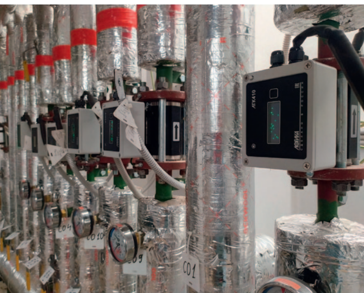
Расходомеры ЛГК410, установленные в торговом центре в микрорайоне «Новая Охта» (Санкт-Петербург)
