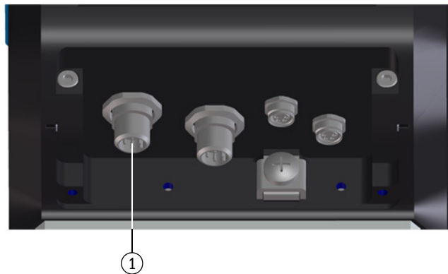
Рисунок 21 Подключение внешнего электропитания внизу у газового счетчика
