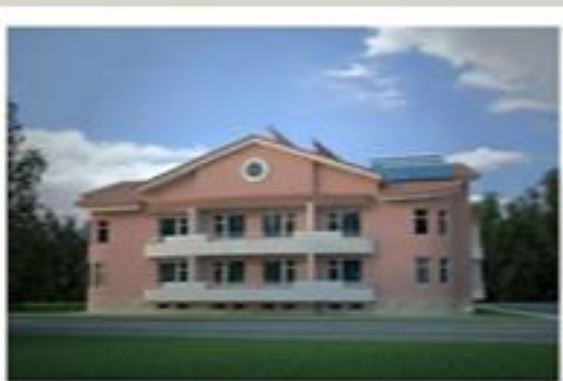
12-квартирный жилой дом «Экодолье» г.Обнинск
